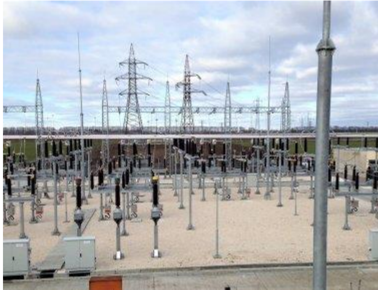
Фигура 6 Примерен изглед на подстанция 33/110 kV
